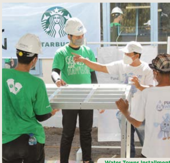
Water Tower Installment Pembuatan Menara Air
